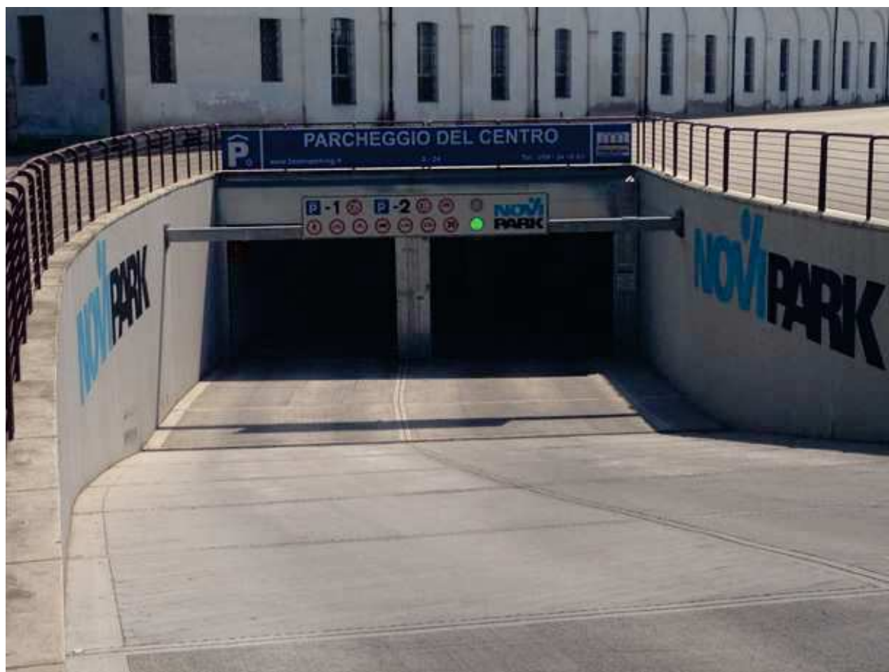
Ingresso del Parcheggio del Centro, capienza complessiva 1720 posti
